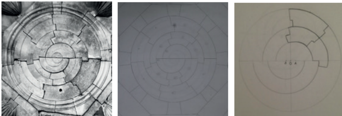
Şekil 10. Tonozun Merkez Kısmı, Spiralin Birleşme Yerlerinin İlerleyişi
