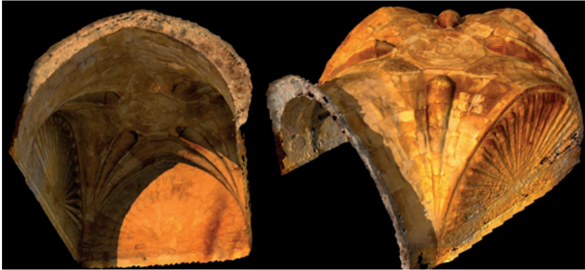
Şekil 4. Divriği Şifhanesi Ana Eyvan Altı Kenarlı Tonozunun Aşağıdan ve Yukarıdan 3D Görünümü (Fabrizio Agnello ve Laura Barrale)
